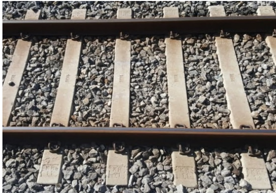
그림11. 철근콘크리트 침목(PC침목)
