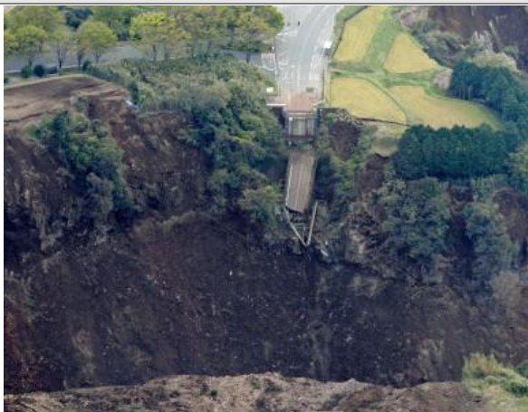
그림 1. 큐슈지진으로 붕괴된 도로 사진
