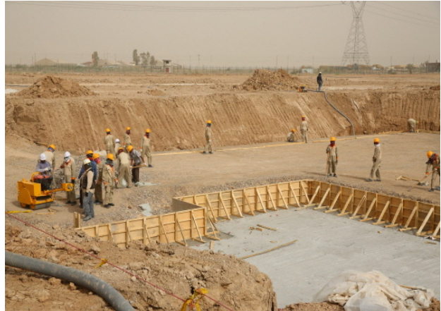
그림 3. 이라크 신도시 건설 공사 진행 중
